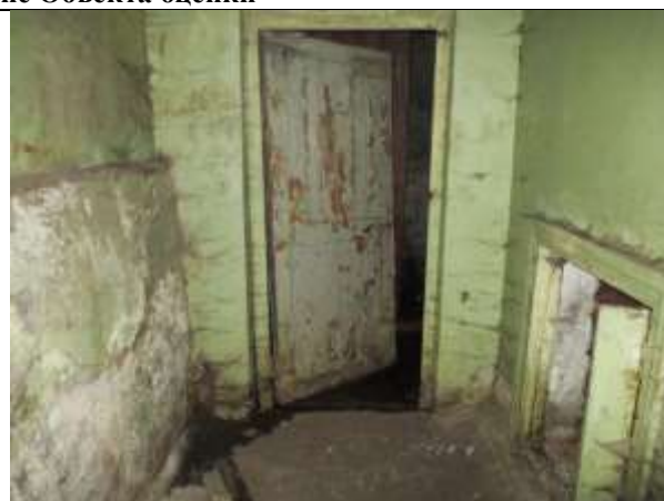
Фото 12. Внутреннее состояние Объекта оценки
