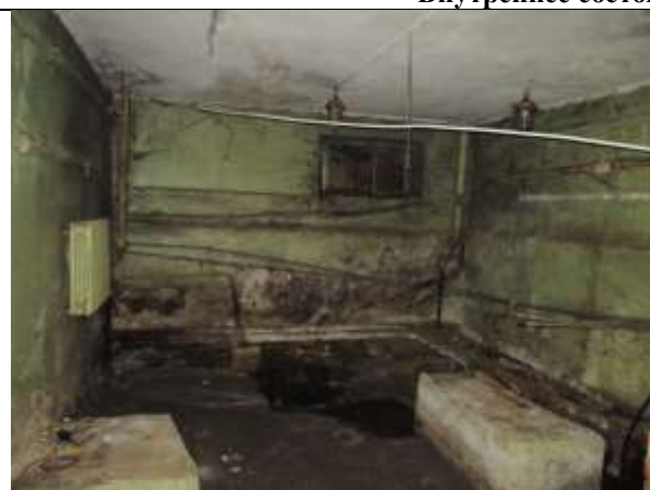
Фото 11. Внутреннее состояние Объекта оценки
