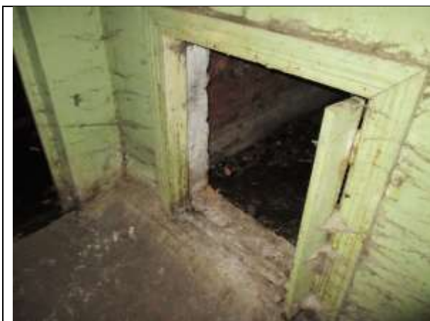
Фото 13. Внутреннее состояние Объекта оценки
