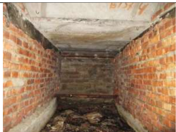
Фото 14. Внутреннее состояние Объекта оценки
