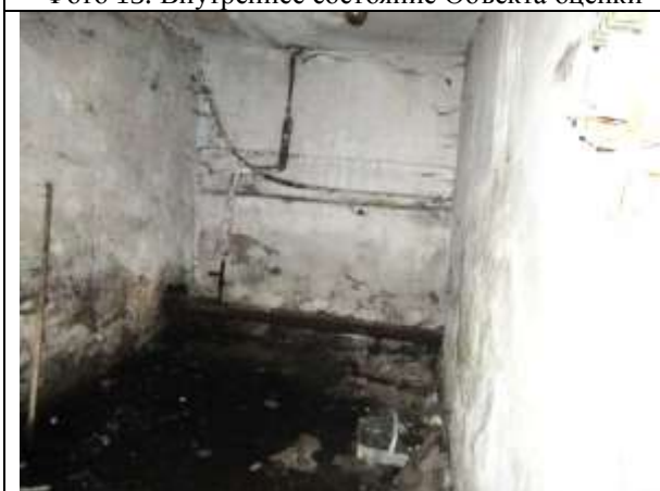
Фото 15. Внутреннее состояние Объекта оценки
